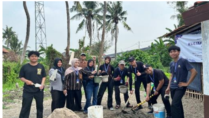
Gambar 4. Proses Pembuatan Tempat Pembuangan Sampah
