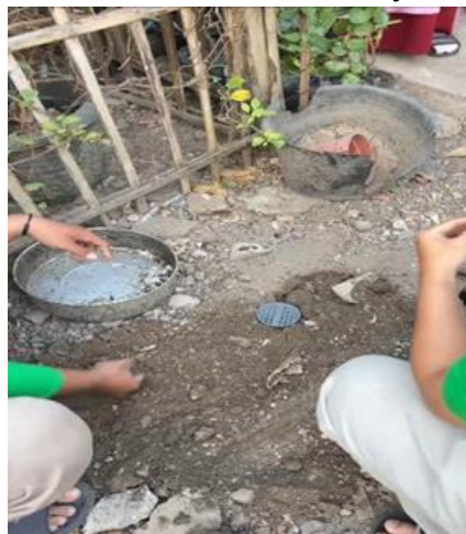
Gambar 5. Hasil Pembuatan Lubang Resapan Biopori di Desa Ngentak, Kelurahan Mojayan
