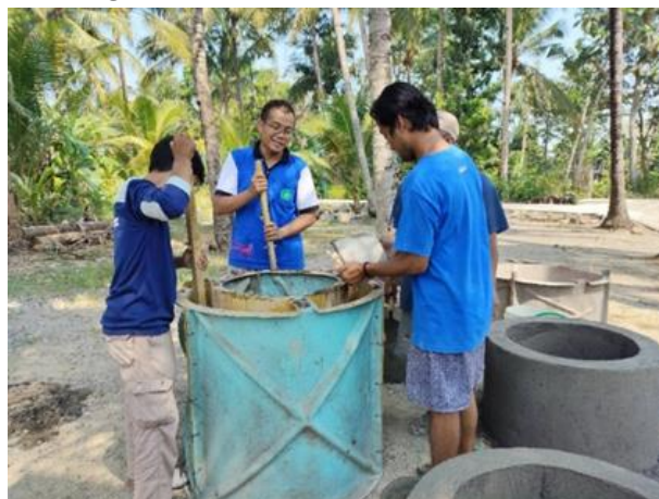
Gambar 9. Pembuatan Buis Beton Menggunakan Alat Cetak
